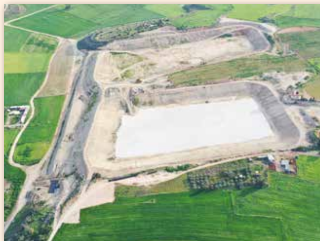
Εικόνα 2 - Δεξαμενές μακροπρόθεσμης αποθήκευσης ανακτημένου νερού
